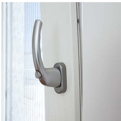
Particolare anta e maniglia con pulsante di sicurezza antieffrazione
